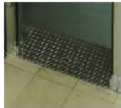
Rampa de Acceso
